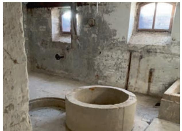
Herr Heitmann (ehemaliger Verantwortlicher der Technik von Schloß Hoym) berichtete, dass er mehrmals in diesem riesigen Auffangbehälter (5 Meter im Durchmesser und 8 Meter tief) tätig war, um Pumpen oder Rohre zu reparieren. Denn seit der Erbauung des Gebäudes und bis zur Wiedervereinigung wurde Schloß Hoym mit Wasser vom Wasserturm aus Richtung Frose versorgt. Das heißt, es herrschte Wasserknappheit, die man mit solchen Zisternen und Vorratsbehältnissen entgegenwirkte
