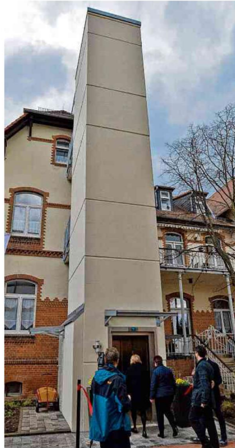
14 Meter hoch ist der Fahrstuhlschacht, der aus Stahlbeton-Elementen besteht und auch im Brandfall benutzt werden darf. FOTO: FRANK GEHRMANN
