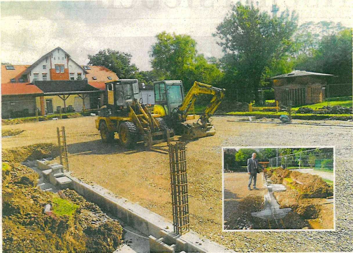
René Strutzberg, Geschäftsführer der Schloß Hoym Stiftung, freut sich über den Fortgang der Bauarbeiten.
